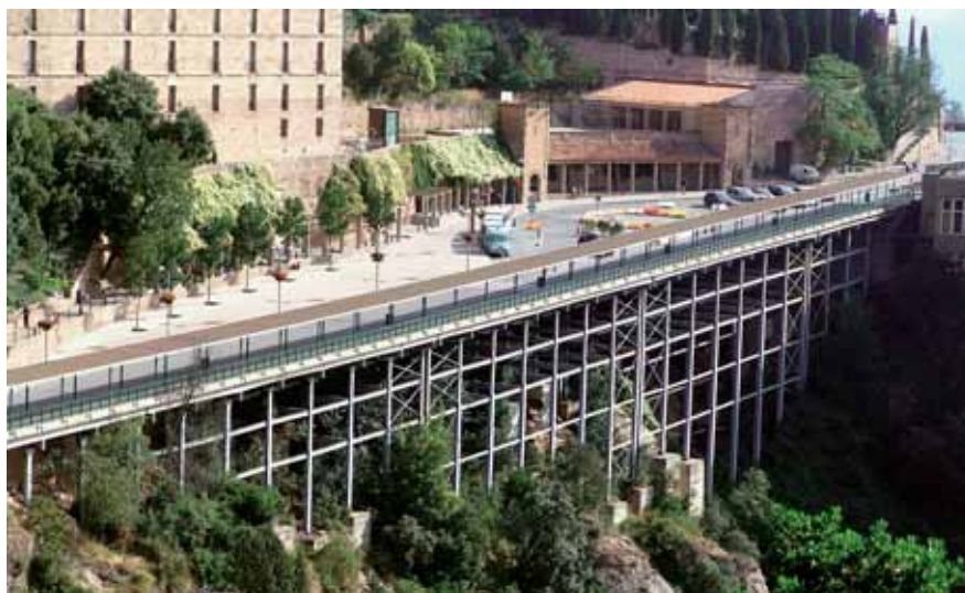
La strada di accesso, una selva di travi d'acciaio
