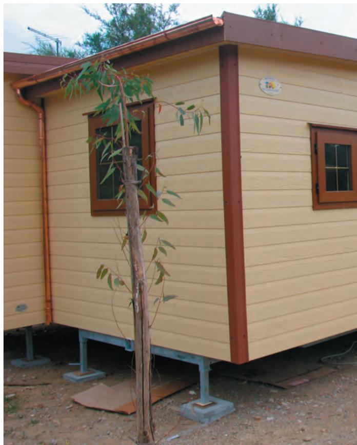
Particolare del sistema di ancoraggio al suolo di una casetta mobile
