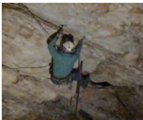
**Operazioni di pulizia e disaggio della volta**
